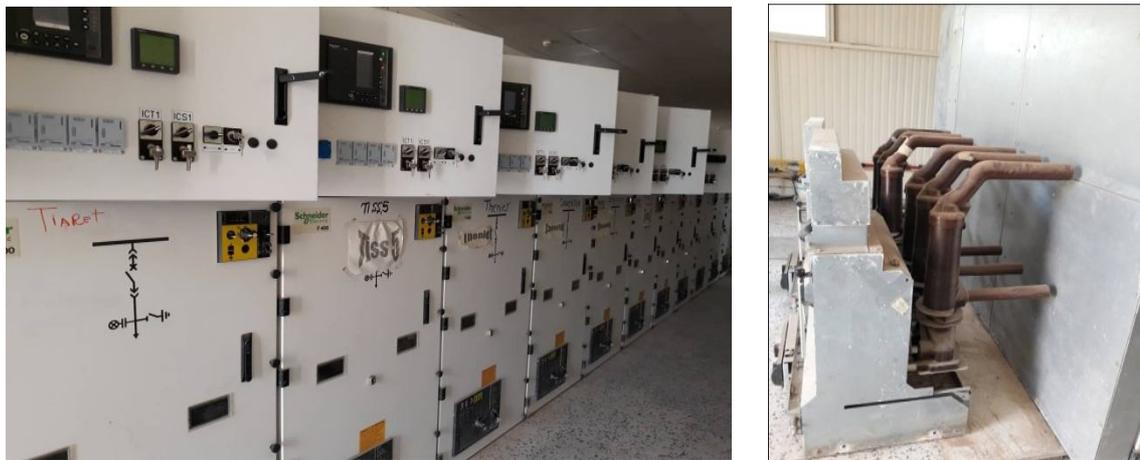
**Figure.III.10** : Cellules des départs 30 KV du poste Tissemsilt
