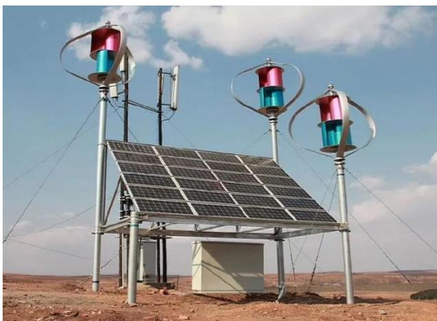
**Fig.8 - Système d'énergie solaire pour les télécommunications [21]**
