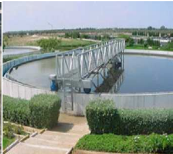
Décanteur secondaire
