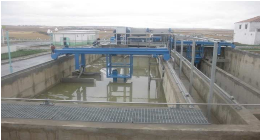
Figure N°05: pompe à sable et racleur ( originale ).
