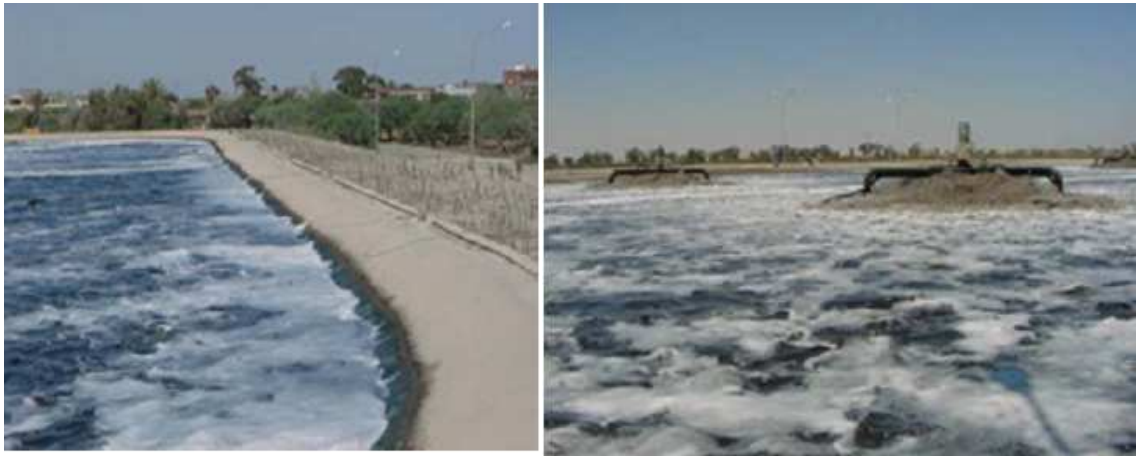
Bord d'une lagune aérée
