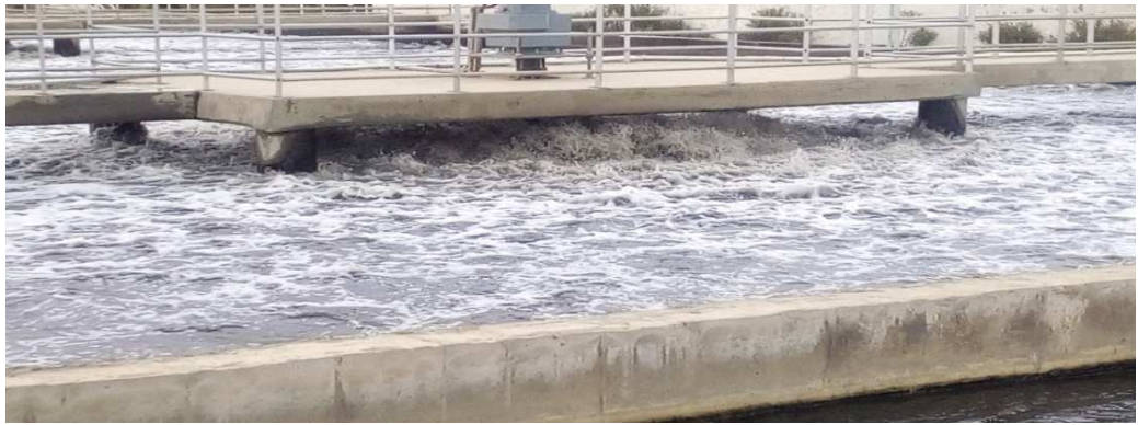
Figure №24: un aérateur, zone oxique (Originale ;2019).
