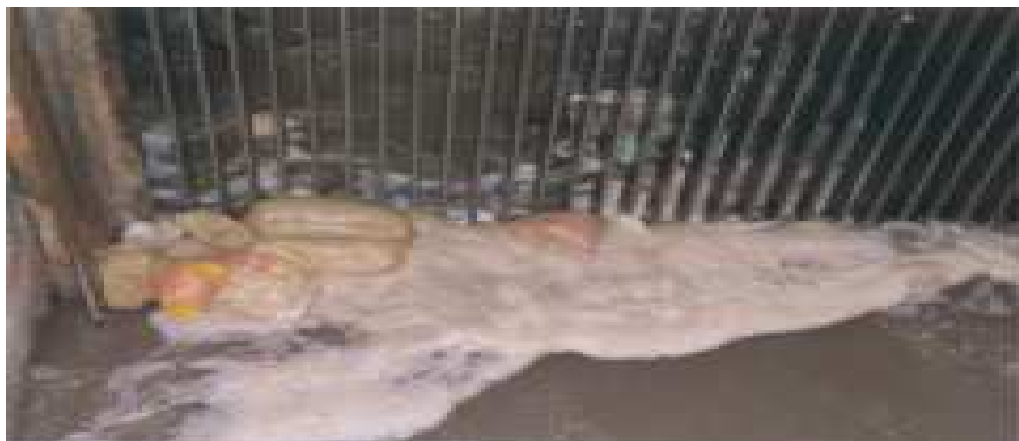
Figure№21 : Le dégrillage.
