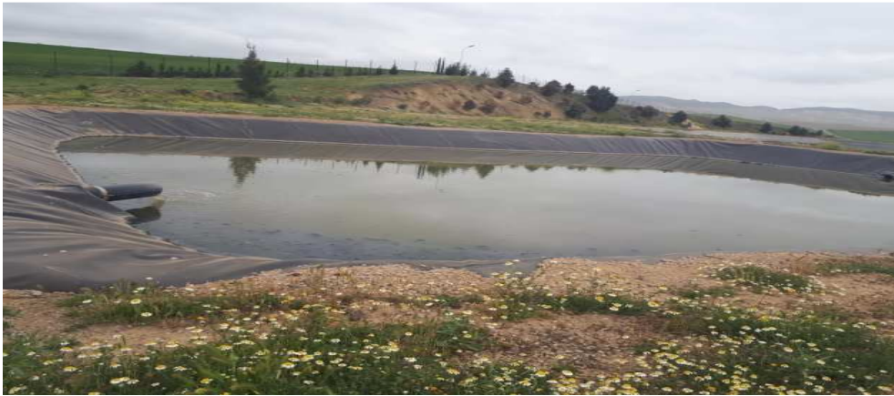
Figure N°29: les deux bassins anaérobiques(Originale ;2019).
