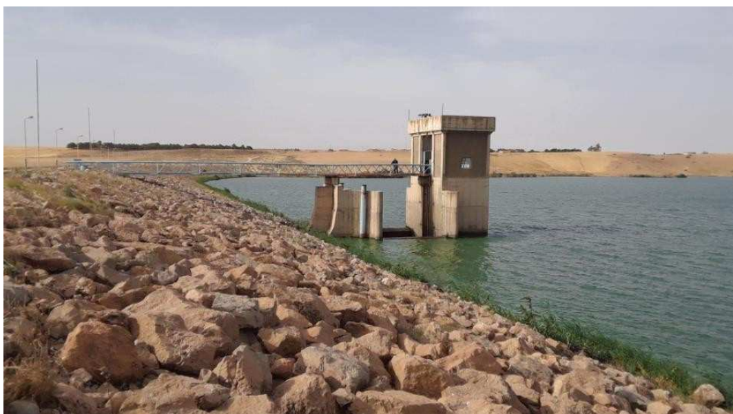
Photo 01 : le réservoir du Barrage Bougara.prise par BETTEKA.S
