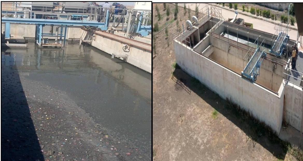
Figure 18: Le bassin de dessablage et déshuilage de la STEP de Tissemsilt.
