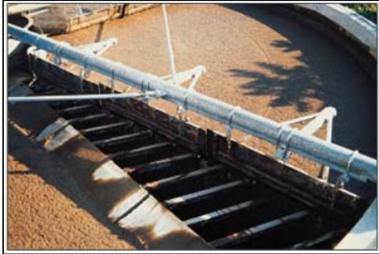
Figure 08: Etape d'épaississement des boues par flottation (Quénéa et Belhadj-Kaabi, 2009).
