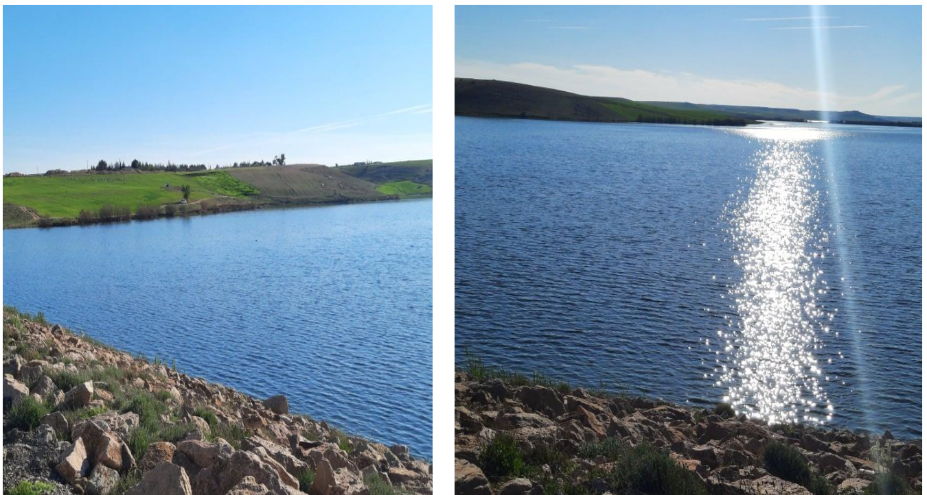
Fig.36 : Vue générale de Barrage Bougara « photo originale, Lardjane.M2021 »
