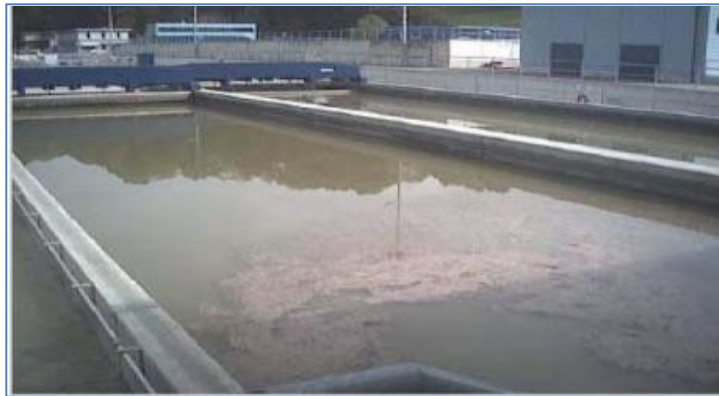
Figure 3 : Bassin de décantation secondaire (Moulins et al, 2013).
