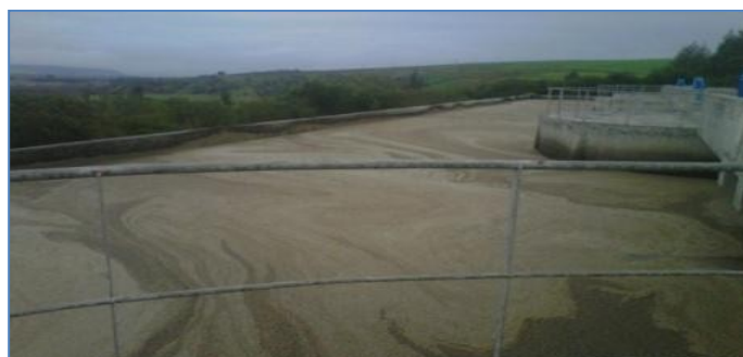
Figure 2 : Bassin de la décantation primaire (Karaali et al, 2009)
