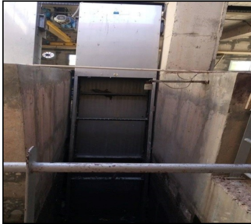
Figure 22 : Dégriilleur grossier
