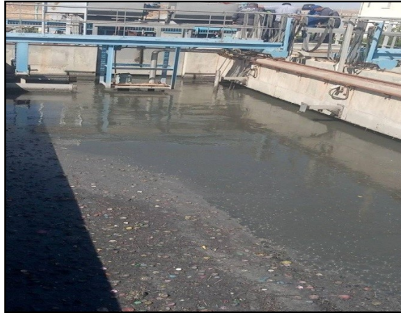
Figure 24 : Le bassin de dessablage et déshuilage de la STEP de Tissemsilt.
