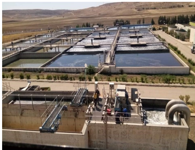
Figure 25 : Bassin d'aération
