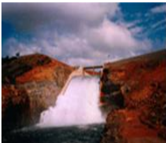
Figure11 :Grafiri (Guinée) : évacuateur de crue à seuil latéral (D.R. Coyne&Bellier).
