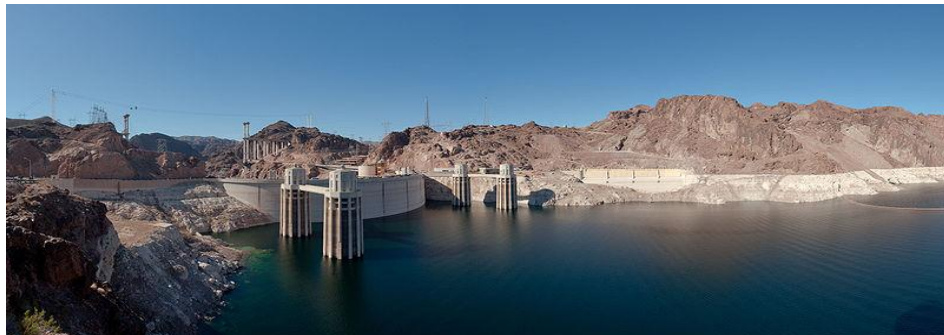
Figure 4 : Barrage Hoover, USA
