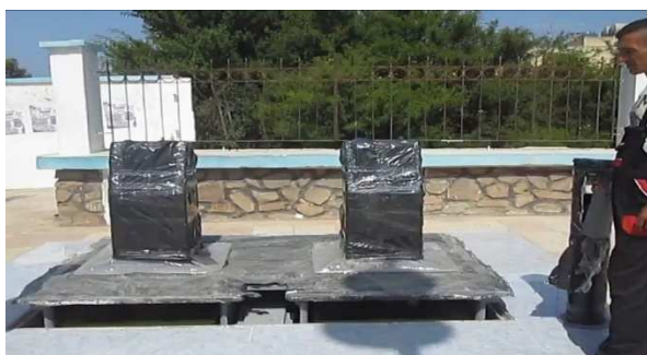
Figure N°03 : les conteneurs enterrés Dans Alger-centre. (DDE. Alger.2016).
