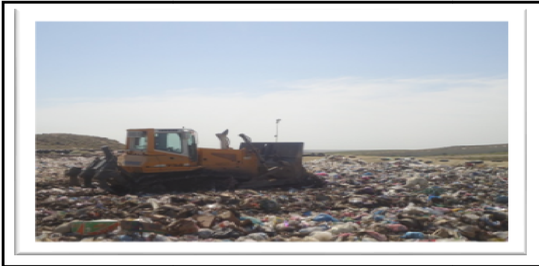
Figure N° 17: l'enfouissement et terrassements.
