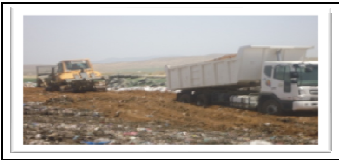
Figure N°18 : un compacteur pour bien compactés la couche extérieure de terre.
