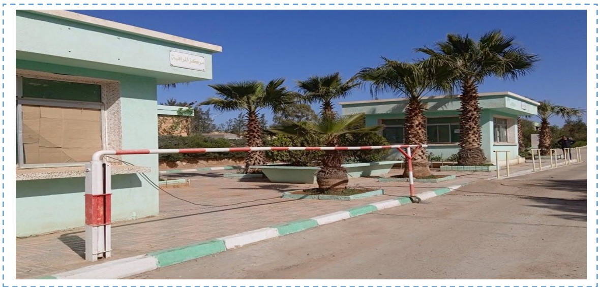
Figure 12: Pont bascule des déchets en CET(Aril,2022).
