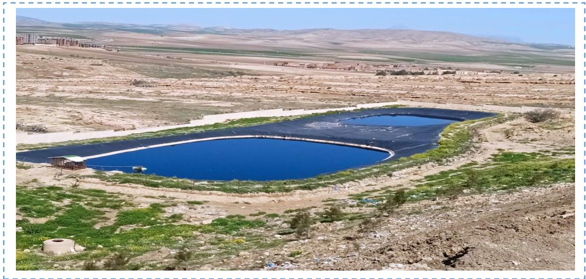
Figure 17 :Les deux bassins de stockage de lixiviat (Avril .2022)
