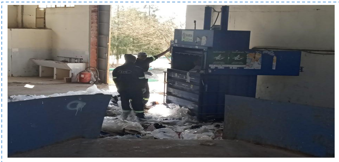
Figure 14: Compacteur à déchets (Avril ,2022).
