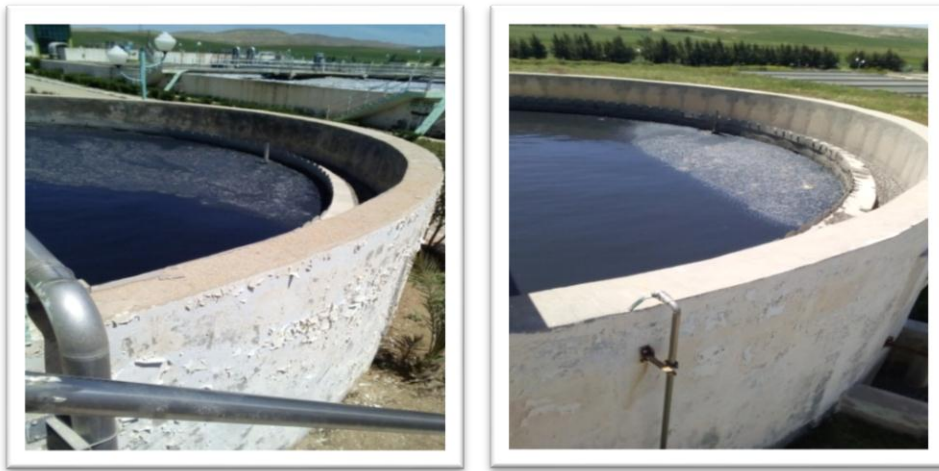
Figure.N° 16:les épaississeurs.
