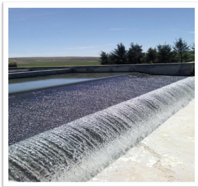
Figure N° 18: la sortie des eaux épurée.
