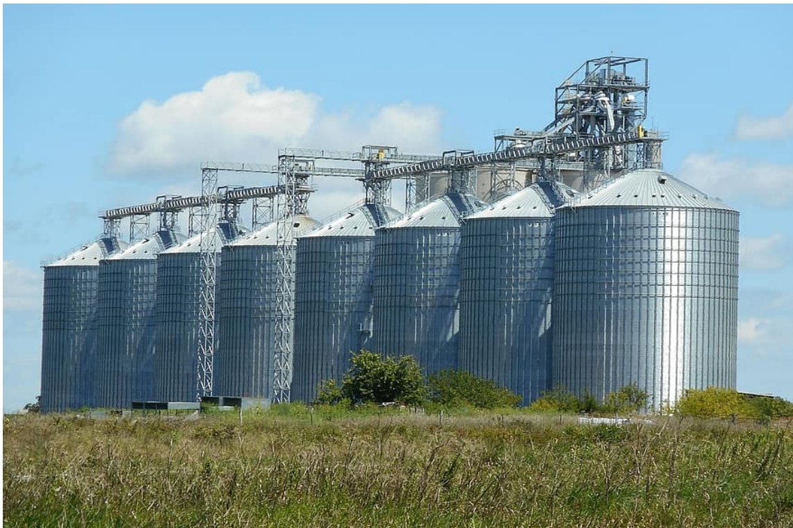
Figure 10. Les silos métalliques
