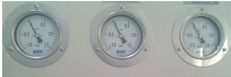
Fig.3.2-les appareils de mesure la pression (manomètres).
