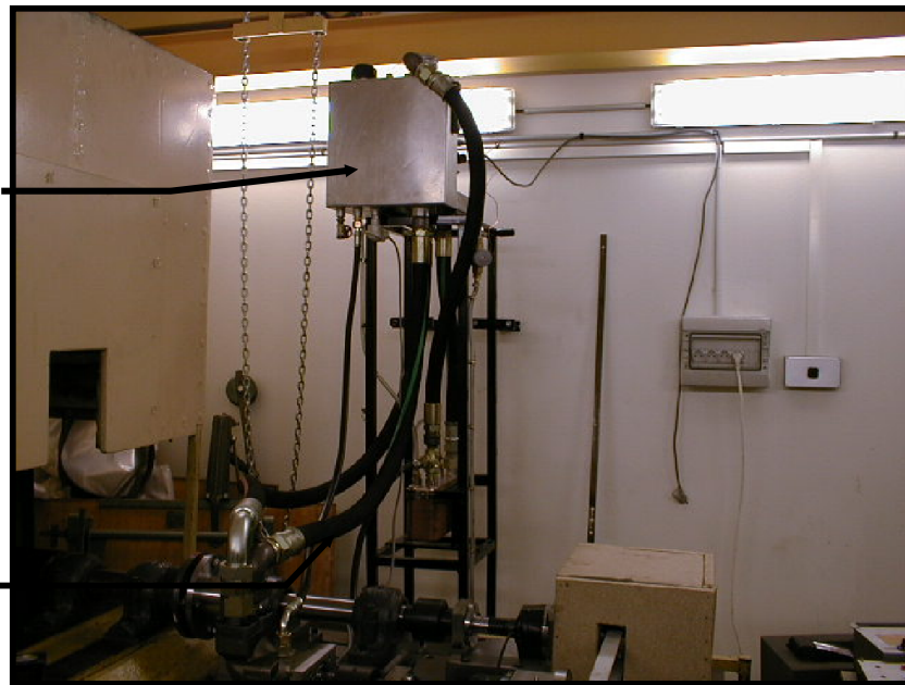
Fig. 3.2 -Vue générale des circuits hydraulique.
