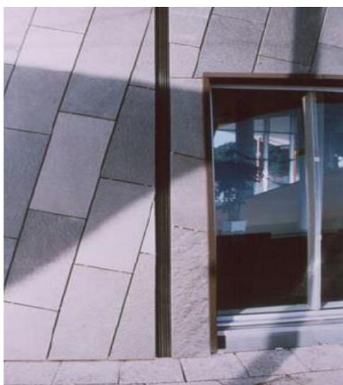
Figure VI.3 : Joints parasismiques entre deux bâtiments. [1]
