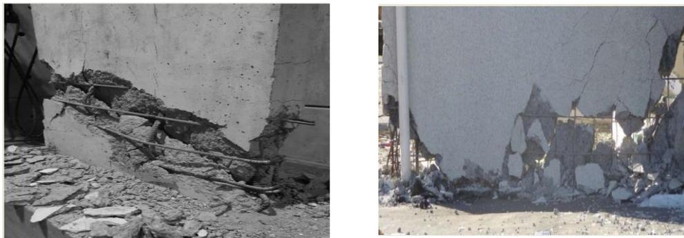
**Figure VI.19 :** Rupture de section à la base du voile. [16]
