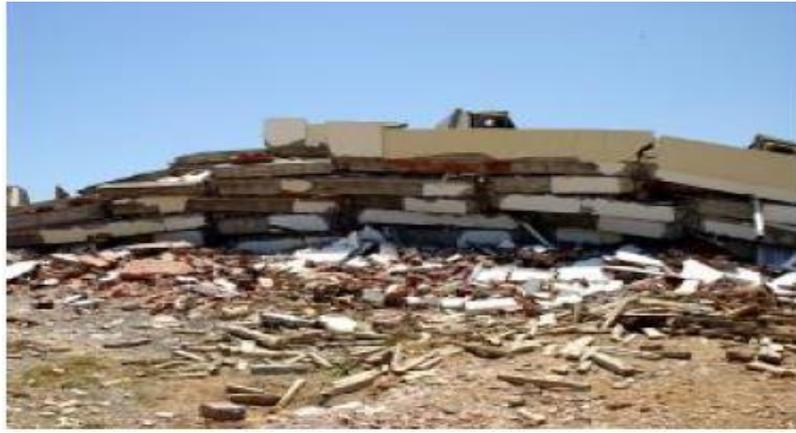
**Figure VI.25 :** Effondrement total des constructions non ou mal contreventées (Séisme de Boumerdes 2003). [5]
