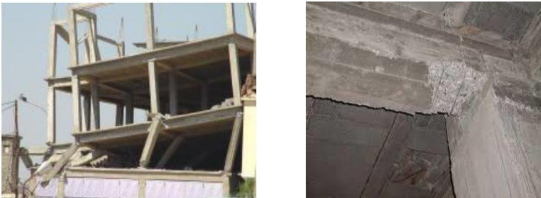
**Figure VI.7 :** Dommages dans l'extrémité des poteaux et des poutres. [14]
