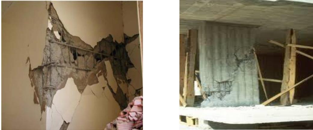
**Figure VI.22 :** Fissures ouvertes dans le voile. [16]
