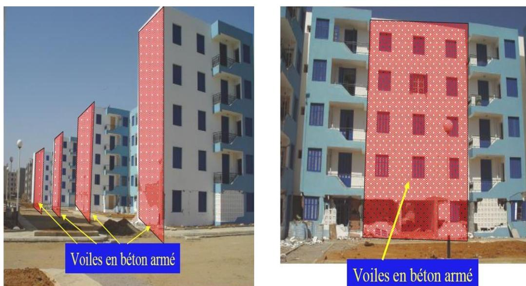
**Figure VI.12 :** Proposition de renforcement par voiles en béton armé (cas 02). [5]
