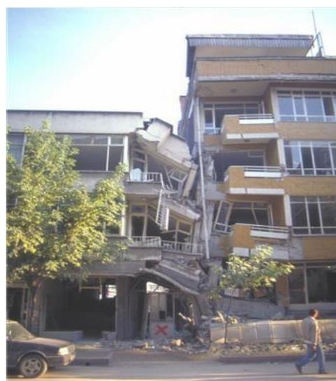
Figure VI.4 : Deux bâtiments qui sont entrechoqués en l'absence de joints parasismiques. [1]
