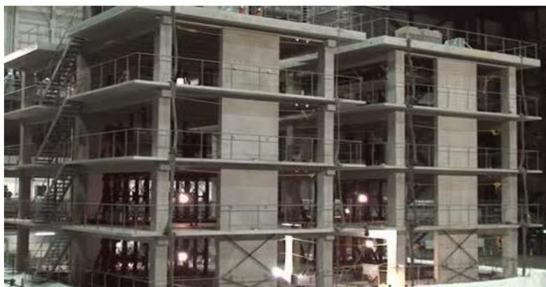
**Figure VI.10 :** Bâtiment contreventé par des murs voiles.
