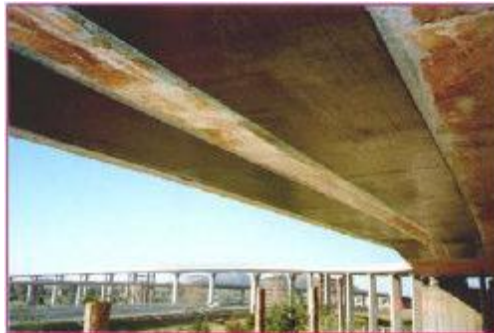
Figure I.35. Renforcement par les FRP installés le long des poutres d'un pont
