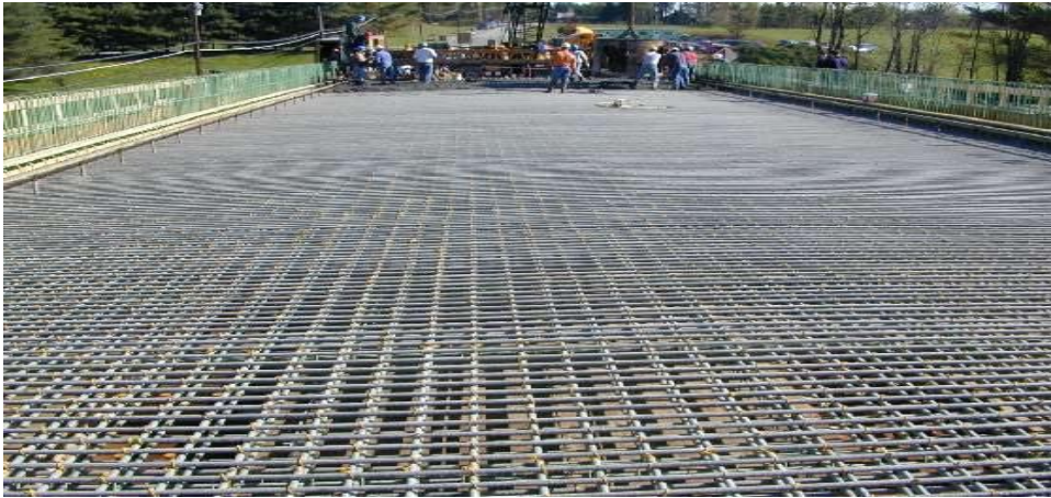
Figure I.41. Barres d'armatures en FRP de verre placé dans un tablier de pont en béton avant le coulage du béton
