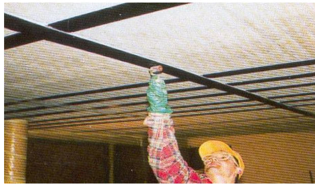
Figure I.38. Emplacement des lamelles composites manuellement
