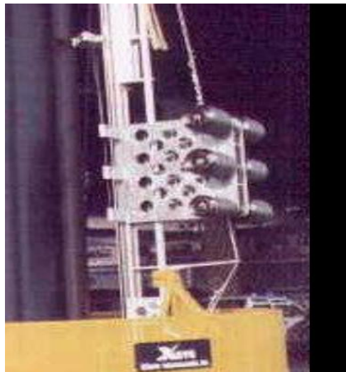
Figure I.40. Colonne entièrement enveloppée par FRP (Enroulement filamentaire)
