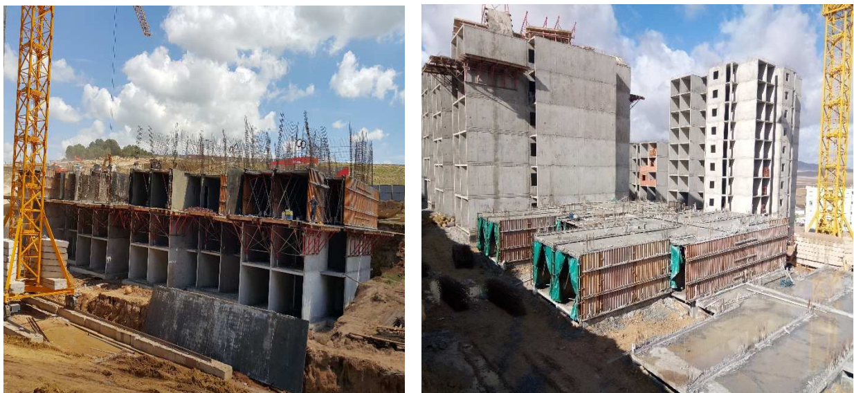
FigI.7. Un aperçu du technique coffrage tunnel sur chantier
