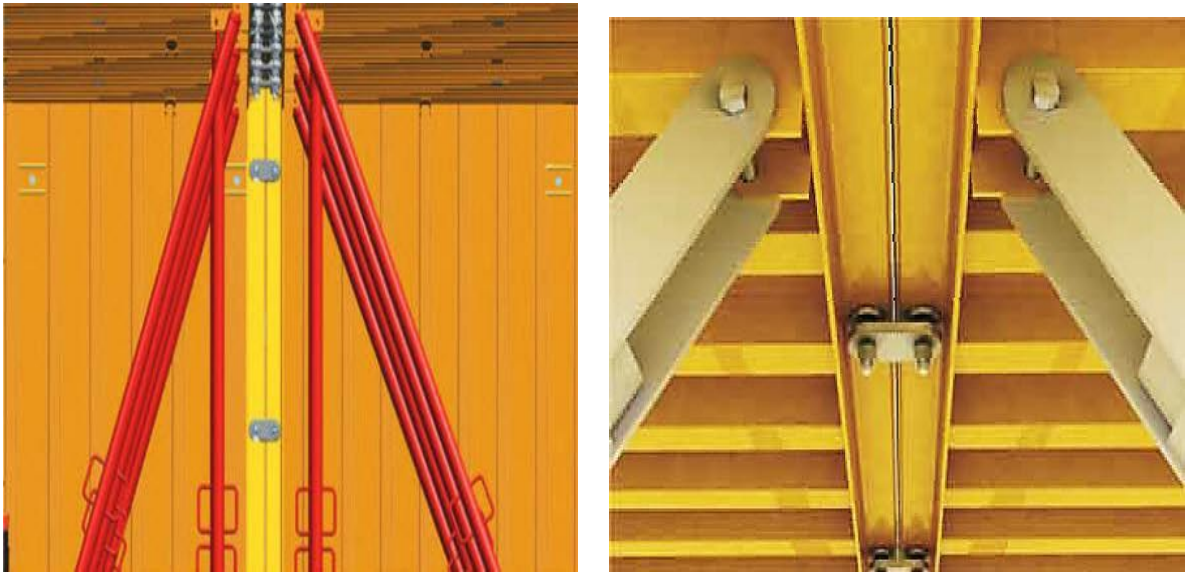
Figure I.11: Solidarisé les deux demi coquilles.
