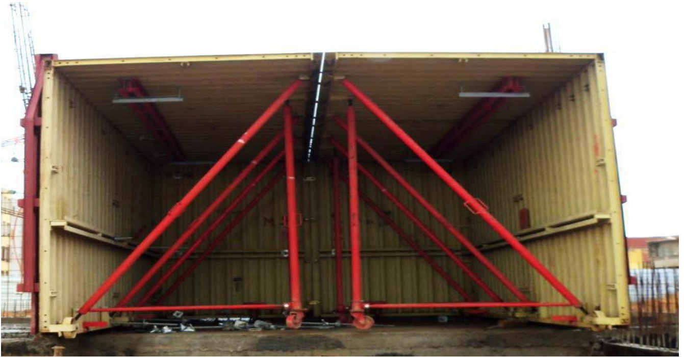
Figure I.5: Assemblage de deux demi-coquilles sur chantier
