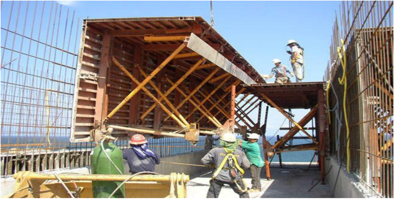
Figure I.3 : Une demi-coquille sur chantier
