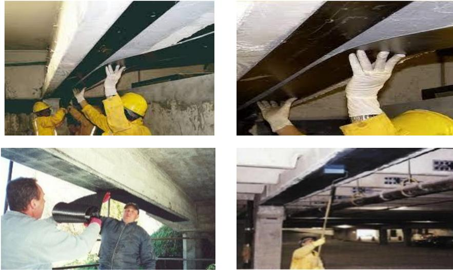
**Figure 2.1:** Renforcement par collage de plaques composites.
