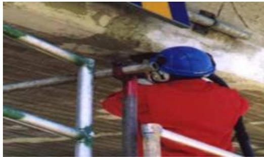
**Figure 2.2** : Réparation avec du mastic.
