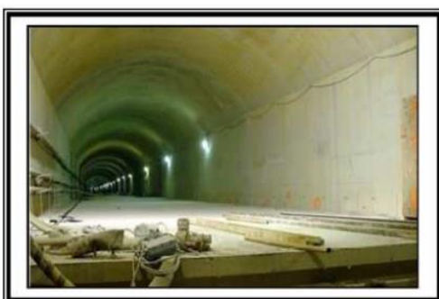
d. Ouvrages souterrains
