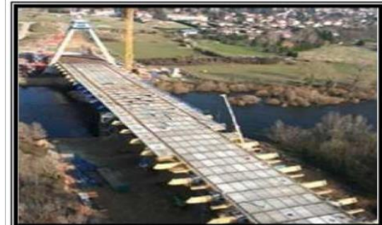
b. Ouvrages d'arts ponts (tabliers)
