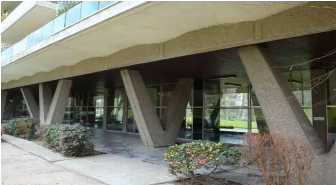
Figure I -10 : Bâtiment contreventé par des colonnes inclinées [11].
