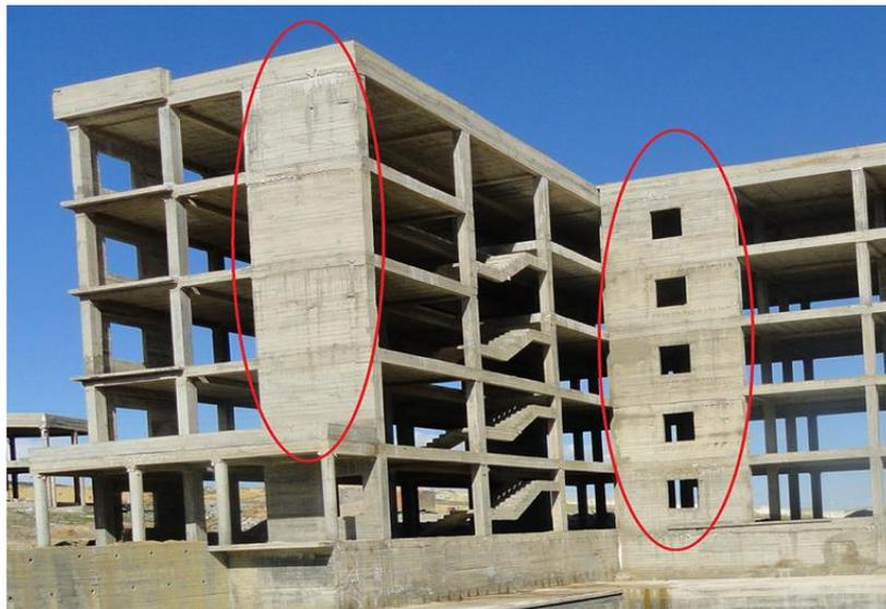
**Figure I - 5 : Voile en béton armé [3].**
