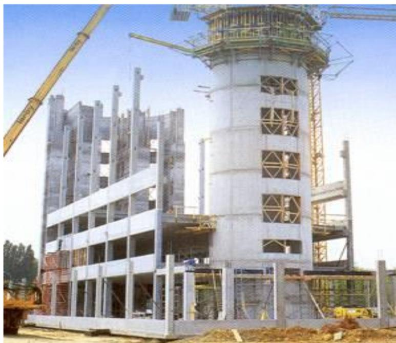
**Figure I - 6 : Noyau complété par des murs transversaux [3].**
