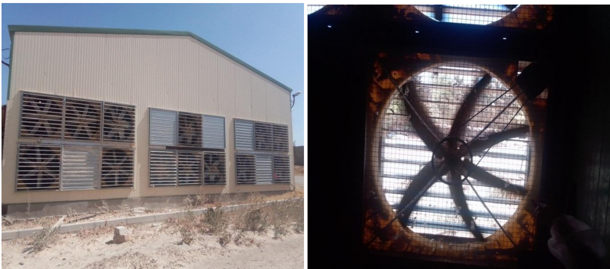
Figure IV.11 : Système d'aération au niveau de bâtiment
