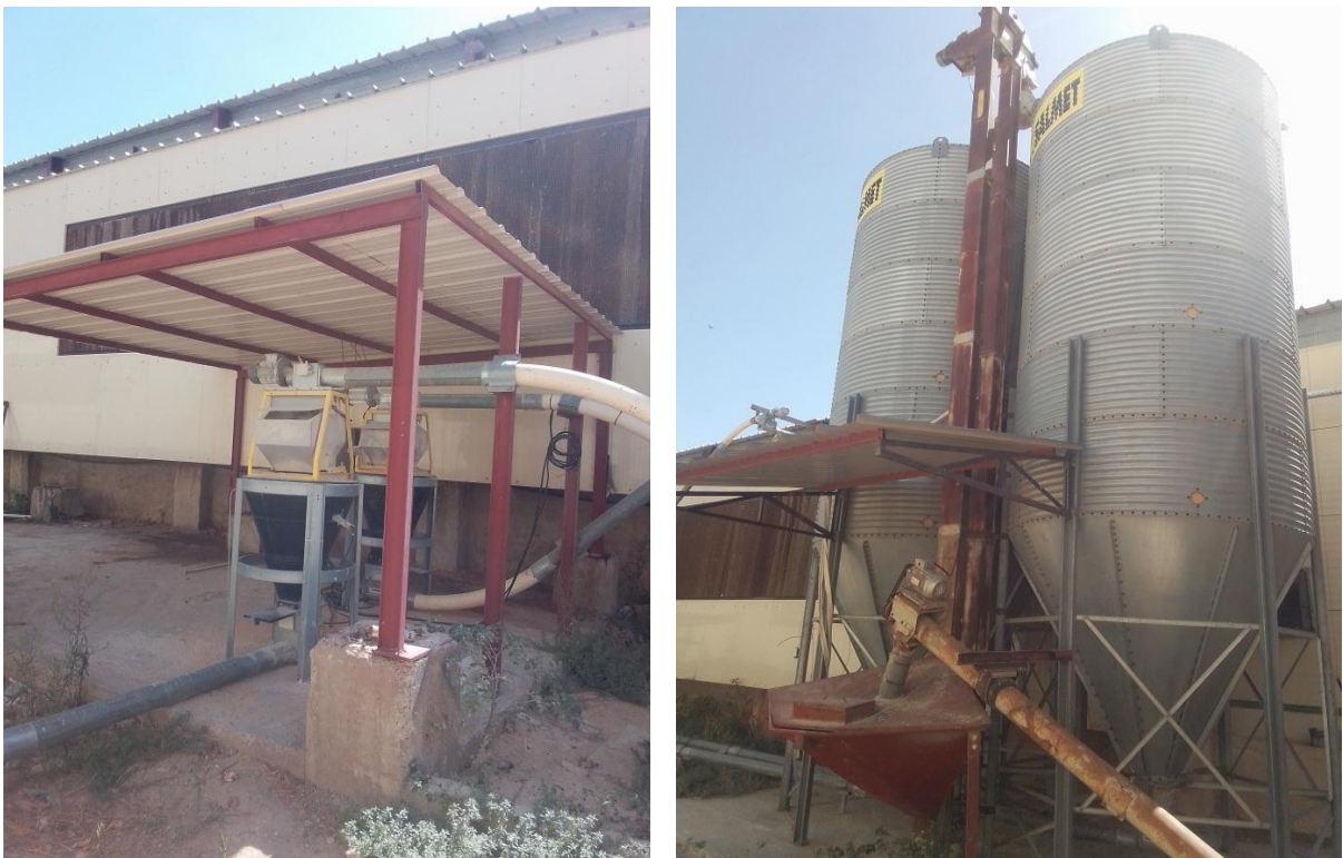
Figure IV.13 : Silos de stockage d'aliment
