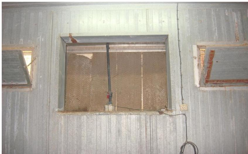
**Fig. n° 06 : Humidificateur (pad-cooling) du clapier.**
