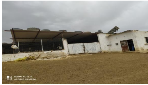
Fig41c : Bergerie semi moderne à Tiaret
