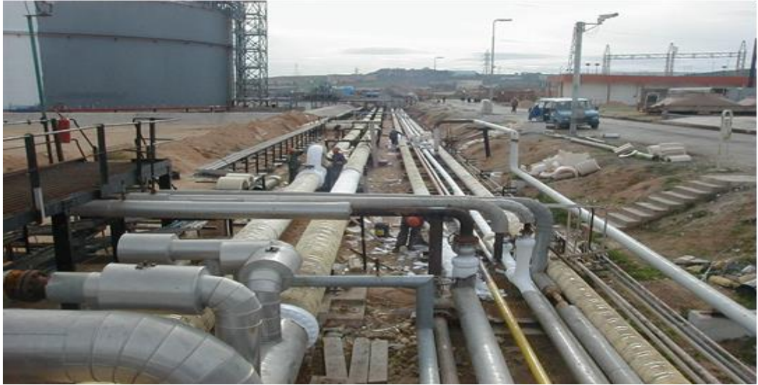
Figure II.3: Lignes d'alimentation de GPL
