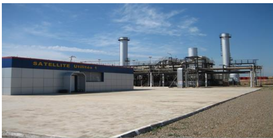
Figure I.5- La zone des utilités
