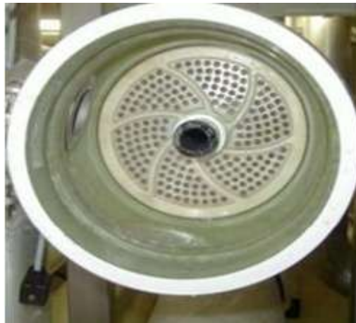
Figure I.5 : Détail d'un tube à pression. [6].
