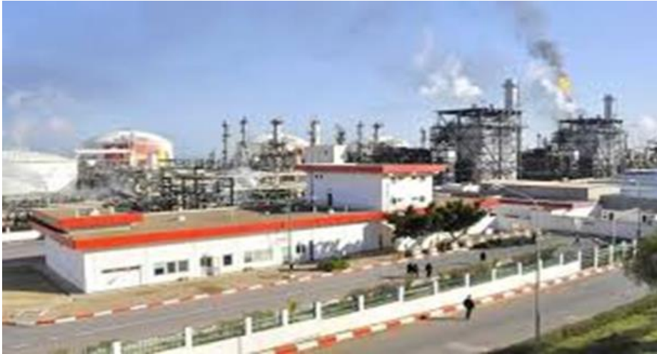
Figure I.2 : photographie de la raffinerie d'Arzew
