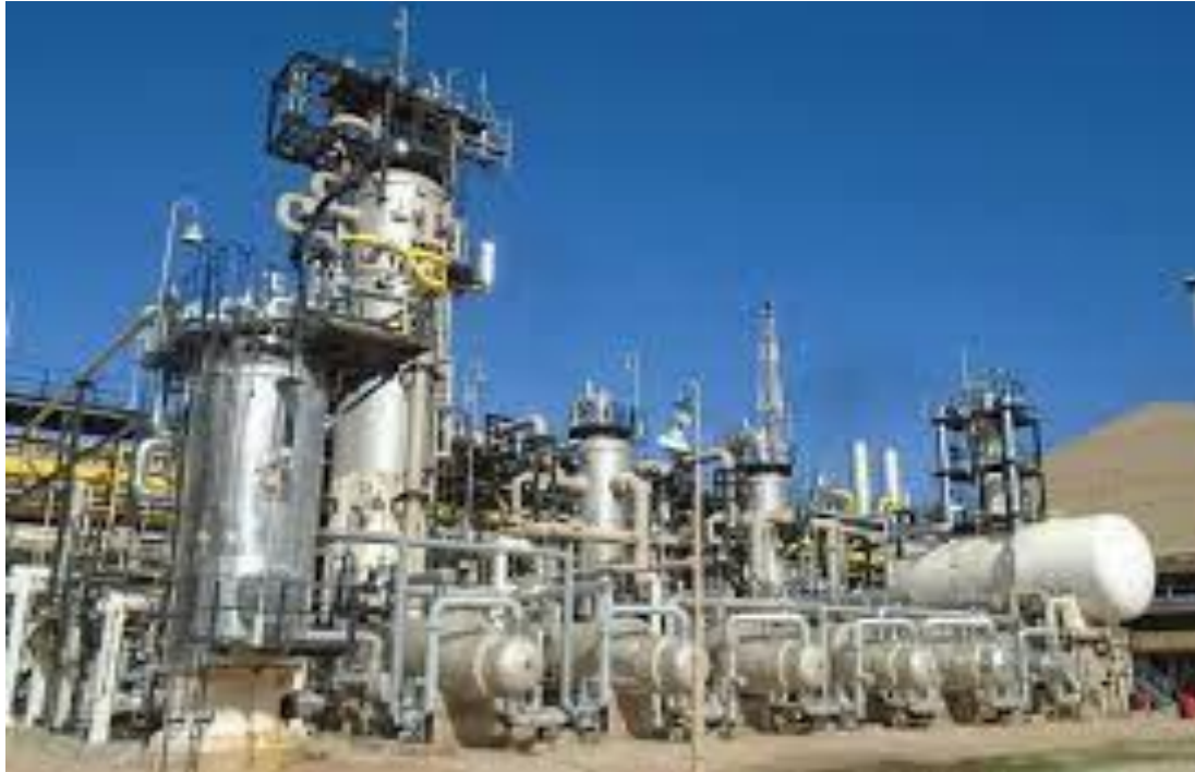
Figure I.3 : Unit de séparation des GPL
