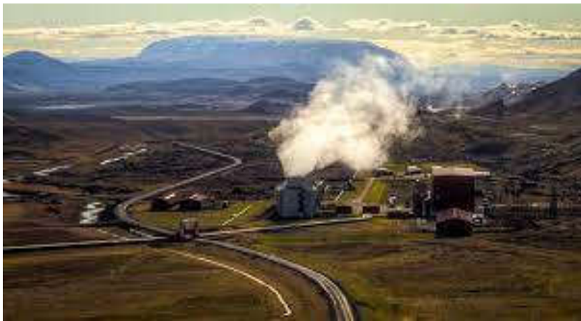
Figure (II-7): La centrale géothermique de Krafla pour la production d'électricité [33]
