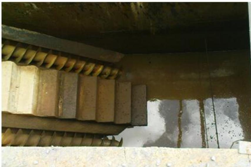
**Figure III-6 : Pompes à vis.**
