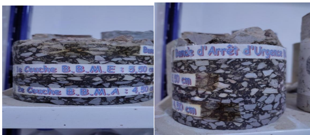
Figure III.8 : Carotte de bonde d'arrêt d'urgence.
