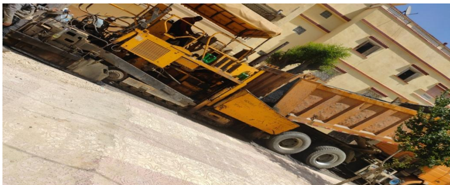
Figure III.9 : le déchargement de béton bitumineux au finisseur.
