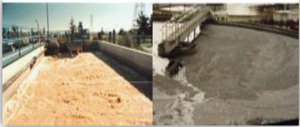
Figure N°22 : Boues activées classiques[1]
