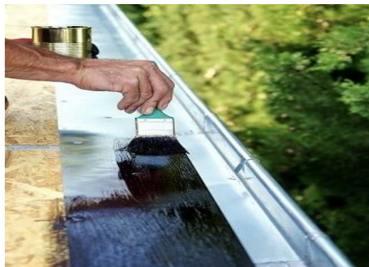
Fig. 19 – Travailleur appliquant un PMB en revêtement imperméable à un toit
