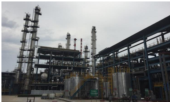
Figure I.8: Unité de distillation de pétrole brut (CDU) [10].
