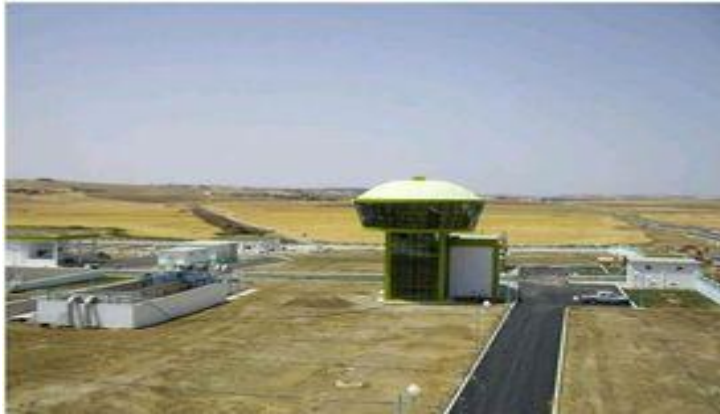
Figure03 : La station d'épuration de TISSEMSILT ( STEP )
