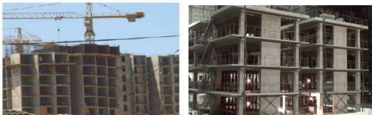
Fig I-4 – Contreventement avec voile en béton armé [5,6]
