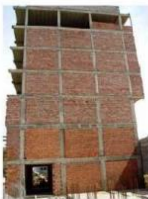
Fig I-5 – Contreventement par remplissage en maçonnerie [5]
