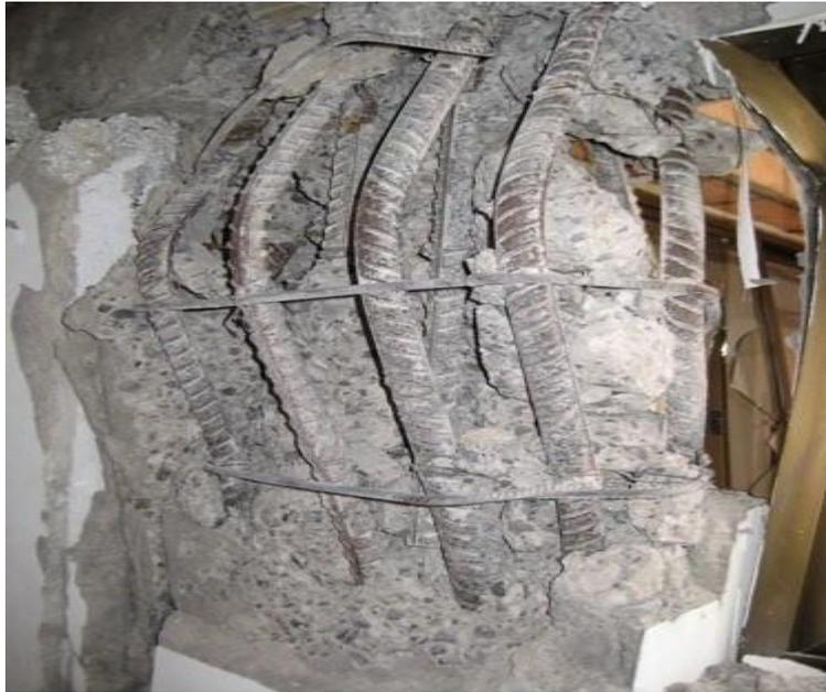
**Figure II.7b** *Flambement des éléments poteaux en béton armé.*
