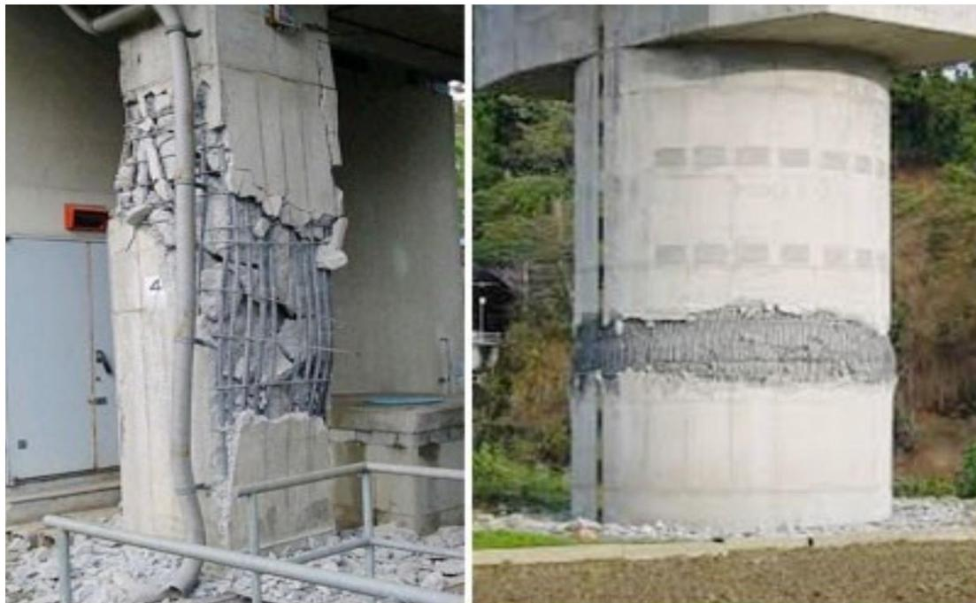
**Figure II.7a** Flambement des éléments poteaux en béton armé.
