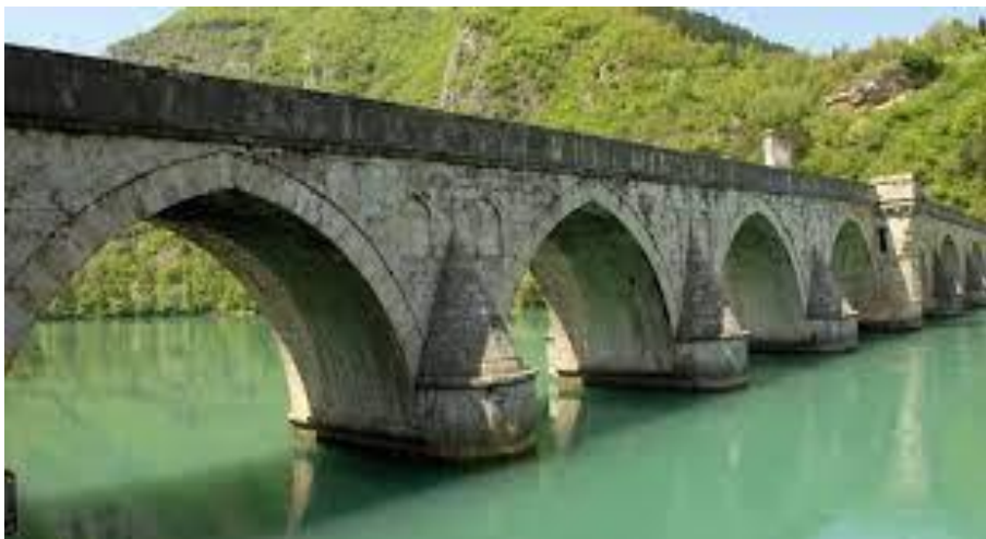
Figure II.2 : Ouvrage d'art (pont)
