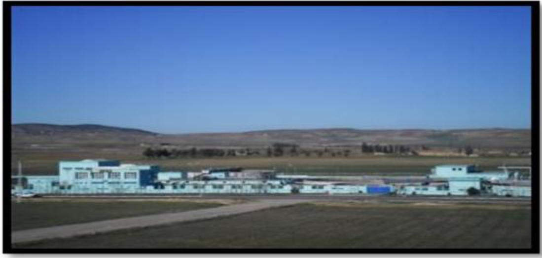
Figure N°08 : La station d'épuration ( Ain Bouchakif ) de la wilaya de Tiaret.
