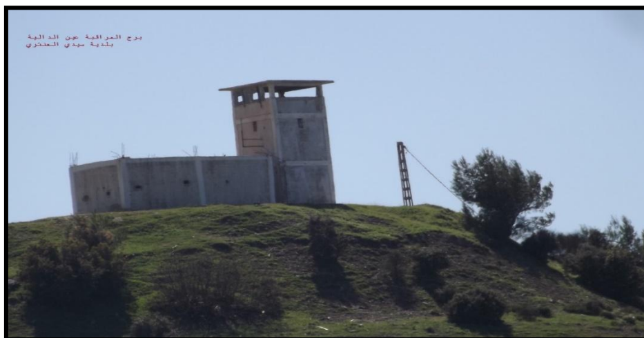
Figure 6 : Poste de vigie au niveau de la région forestière de Lardjem (Photo prise le 08/05//2022)
