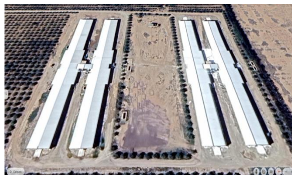
Photo 2: Etablissement avicole privé situé à RDJEL- RECHIGUA (photographie vue du ciel de Google Maps, 2024)
