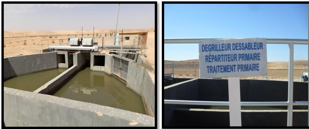
Figure 6: Dégrillage/dessablage
