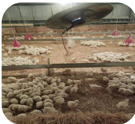
Figure 16: Système de chauffage par radiants à gaz en phase de démarrage
