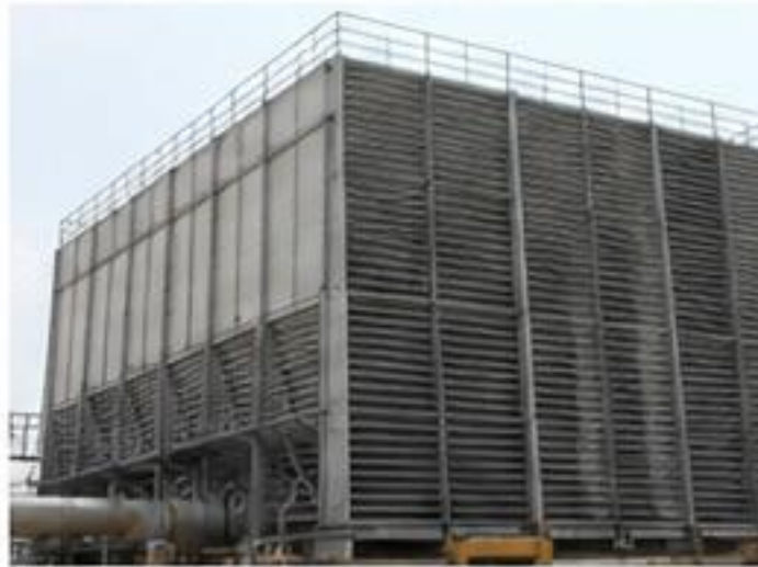
Figure II.6 : Aéroréfrigérants à circulation naturelle.
